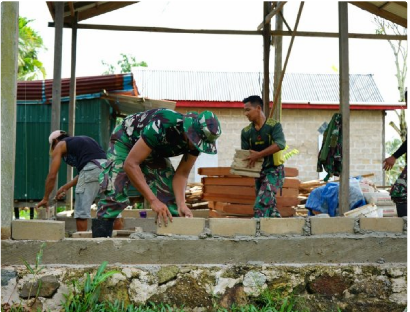
Rehab Rumah Warga, Satgas TMMD 116 Kodim 0907/Trk Selalu Mengedepankan Kualitas
