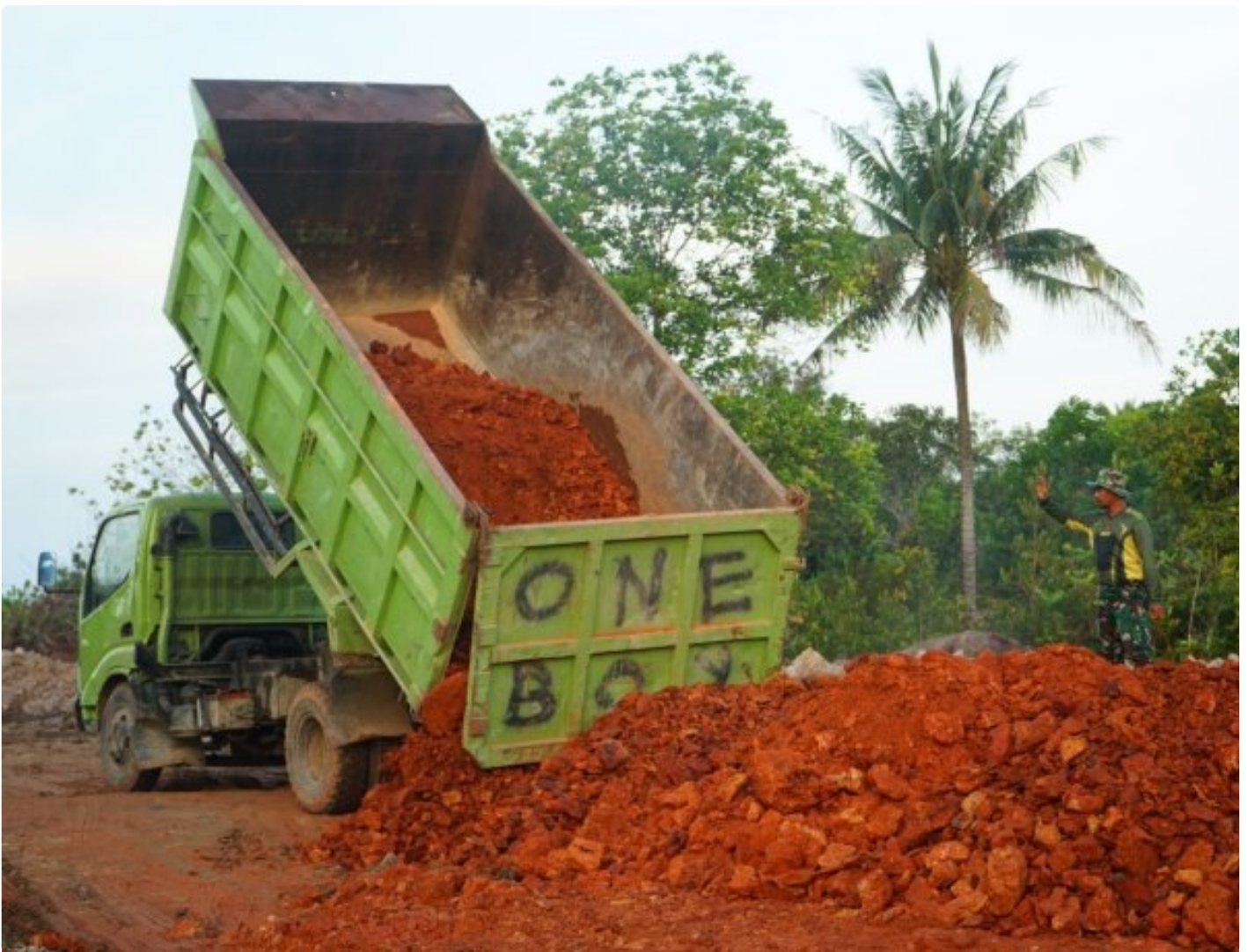
Percepat Pengerjaan Jalan,Material Dan Alat Terus DiKebut Satgas TMMD Di Tarakan
